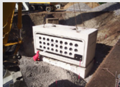
Het plaatsen van een diffusiewand
