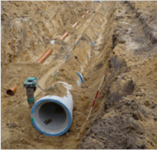
Het gefaseerd aanvullen van de sleuf
