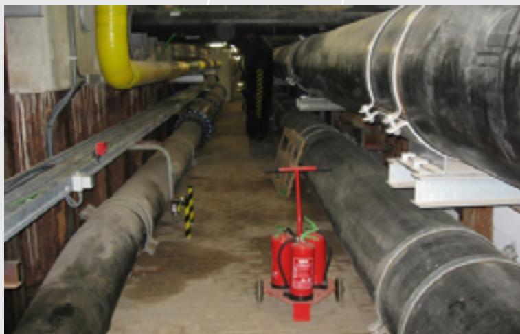
Meervoudig gebruik: Leidingkoker in stedelijk gebied, voorkomt maatschappelijke overlast bij aanleg en onderhoud
