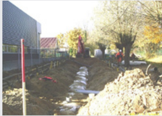
De sleuf is bijna aangevuld
