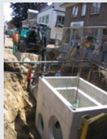
Montage van een overstortput
