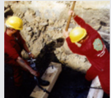
Aanbrengen van polystyreen stroken
