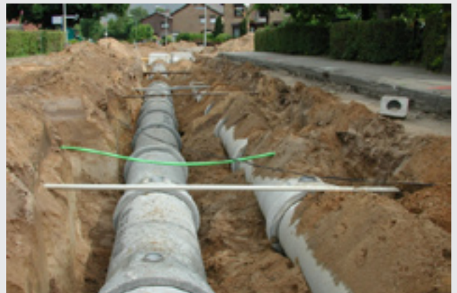
Buizen met de huisaansluitingen aan de bovenzijde
